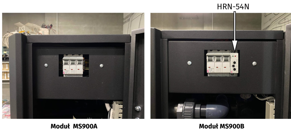
Rysunek 26. Włączanie wyłączników automatycznych
