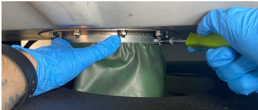
Рисунок 21. Монтаж манжеты сливного отверстия
