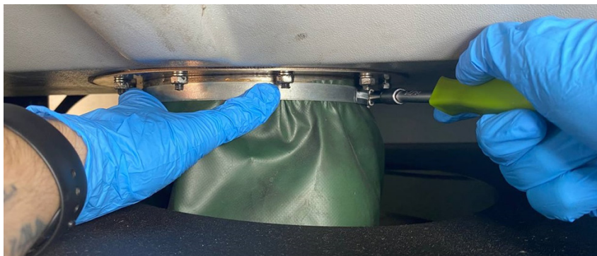
Rysunek 21. Montaż mankietu spustowego
