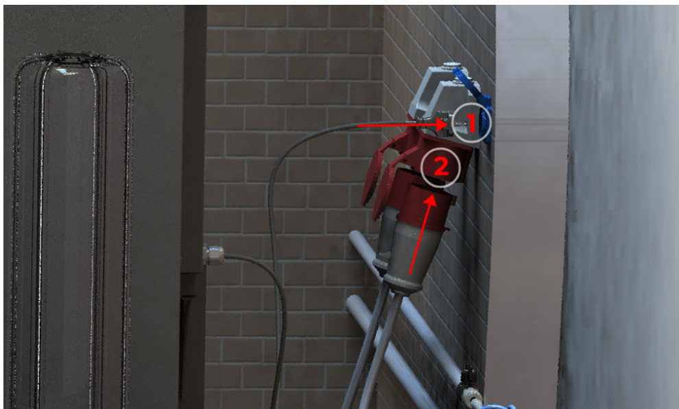
Рисунок 23. Подключение электропитания комплекса
