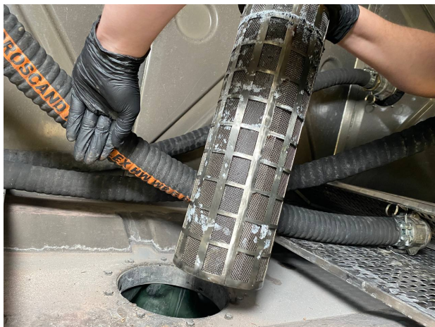
Figura 46. Filtro del tanque desmontado
