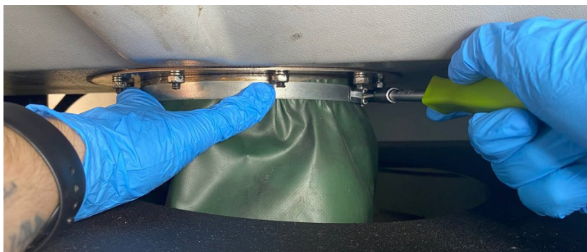
Figura 21. Instalación de la manguita al orificio de drenaje
