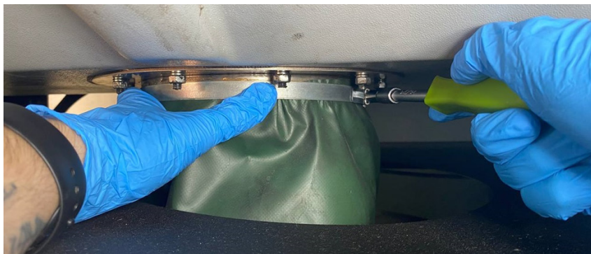
Рисунок 21. Монтаж манжети зливного отвору
