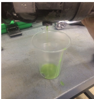
Rysunek 21. Kontrola stanu oleju sprężarki
