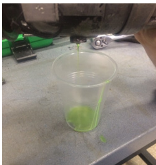
Figura 21. Control de estado del aceite del compresor
