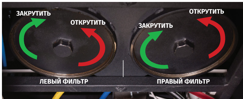
Рисунок 37. Направление вращения крышки при замене фильтров MS0101
