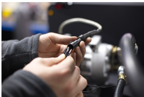
Rysunek 27. Podłączenie przewodów sterujących do sprzężarki
